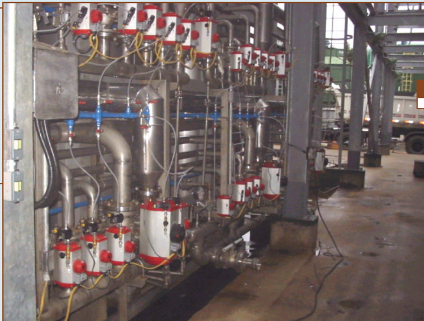
F.5 Menos cabos, calhas e eletrodutos para encaminhamento até o painel.
