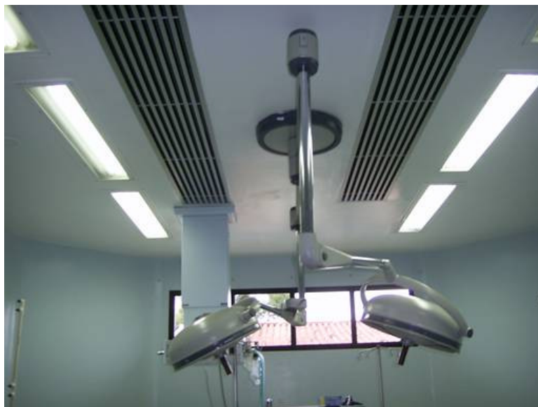
Figura 8.5 B – Vista do insuflamento (Sala Cirúrgica C)
