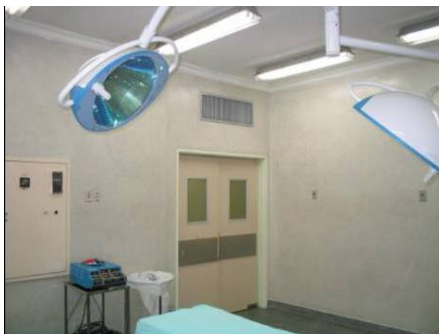
Figura 8.1B – Vista geral da sala, mostrando a grelha de insuflamento (Sala cirúrgica A)
