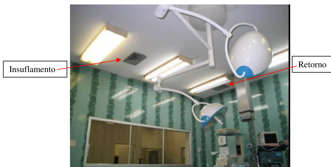
Figura 8.3-B – Vista do insuflamento e do retorno (Sala Cirúrgica B)
