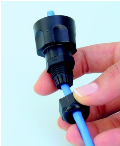
Figura 8 – Inserir a porca de compressão e o invólucro no cabo.
