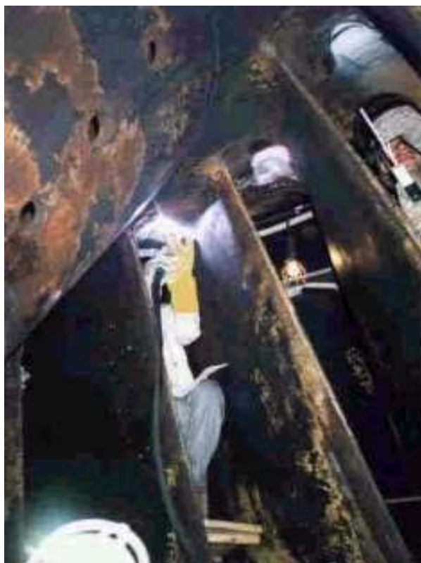
Figura 1.3 – Soldadores entre as pás da turbina [24].
