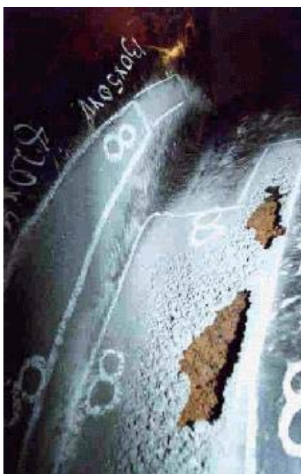
Figura 1.1 – Zona erodida pelo efeito da cavitação na pá de uma turbina Francis [24].
