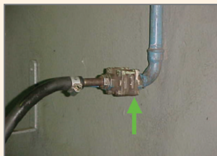
F.2 Vazamento no espigão da válvula.
