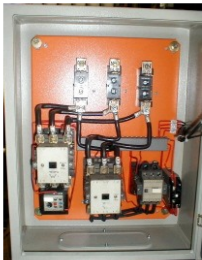
Chave de partida estrela- triângulo para motor 30 HP – 220V. Fonte: www.cadiriri.com.br
