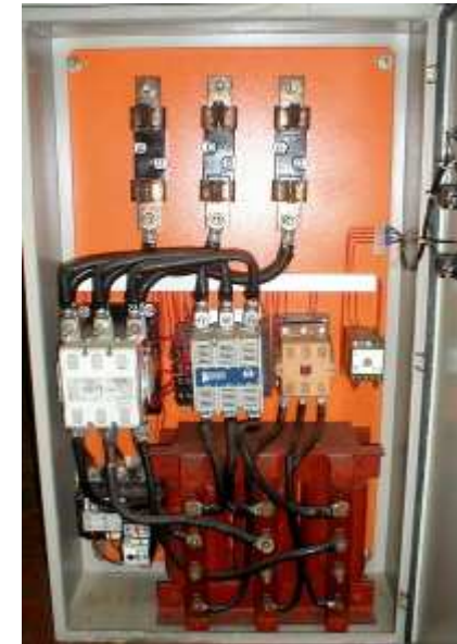
Chave de partida compensadora. Fonte: www.cadiriri.com.br
