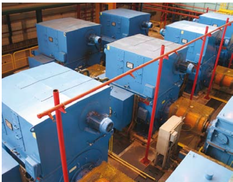
Motores Síncronos SDL800, 3.000 kW, 3.100 V Aplicação: Laminadores (siderurgia)
