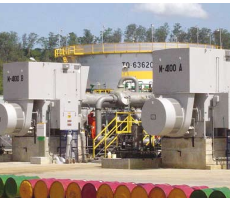
Motores Síncronos SEF900 (Ex-p), 3.600 kW, 13.200 V Aplicação: Compressores recíprocos
