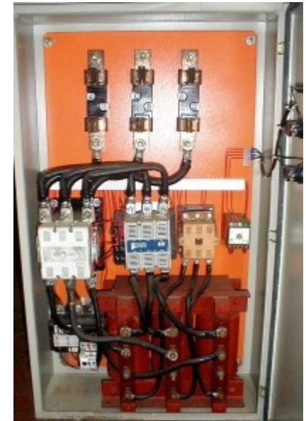
Chave de partida compensadora. Fonte: www.cadiriri.com.br
