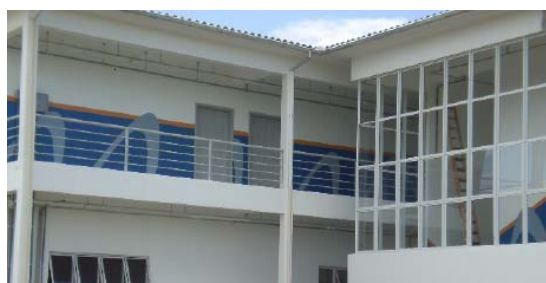
Figura 1.14- Foto da Unidade Araranguá
