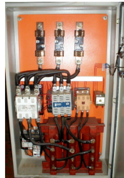
Chave de partida de compensadora. Fonte: www.cadiriri.com.br
